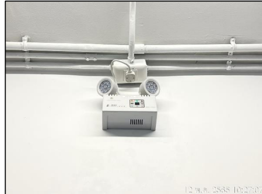
ภาพที่ 55 ไฟฟ้าสำรองฉุกเฉิน
