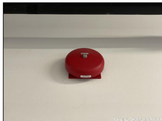
ภาพที่ 17 กริ่งสัญญาณแจ้งเหตุเพลิงไหม้
