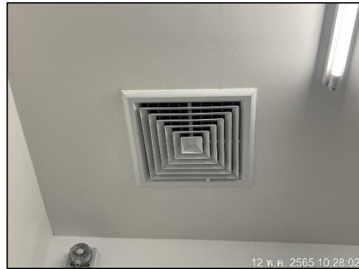
ภาพที่ 30 ระบบระบายอากาศบริเวณห้องพักมูลฝอย
