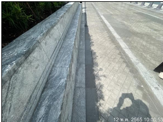
ภาพที่ 31 รางระบายน้ำรอบบริเวณพื้นที่โครงการ
